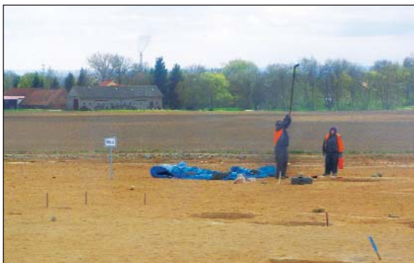
Pokračování stavby D11 k Hradci Králové začalo vyměřováním a skryvkou ornice. FOTO – M. VOHRALÍKOVÁ
